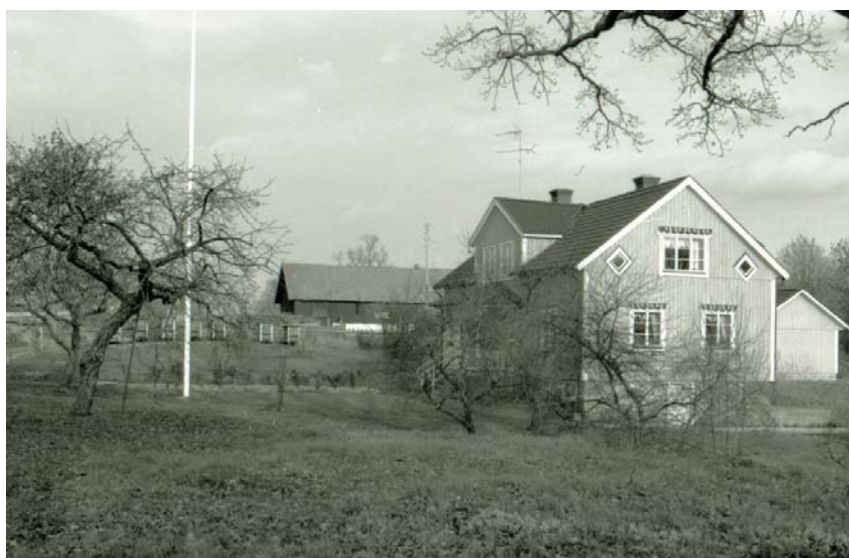
Mangårdsbyggnad och den del av ekonomibygnaden som revs 1982.
