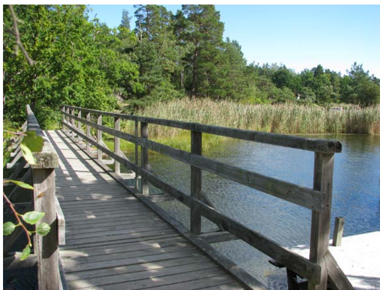
Gångbro över till Uvö.
